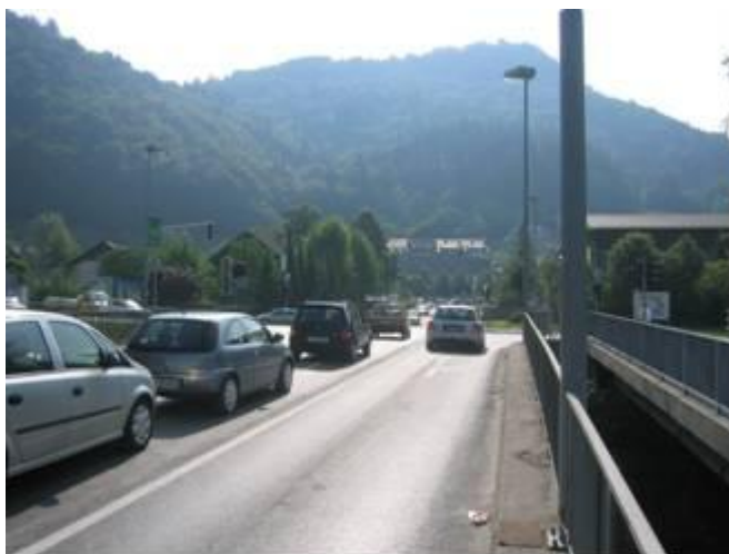
Slika 6: Dovoz v križišče Šolske in Kamniške obvoznice iz zahodne smeri preko mostu (avtor: Borec, 2006)
