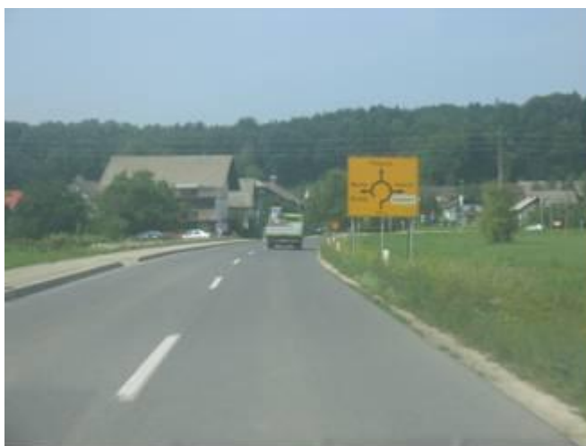
Slika 12: Križišče Korenove ceste in glavne ceste Kamnik –Moste (avtor: Borec, 2006)
