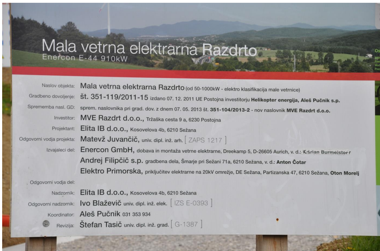
Slika 3: Gradbiščna table za izgradnjo vetrne elektrarne Razdrto, 16. 4. 2014 Vir. dr. Drago Papler
