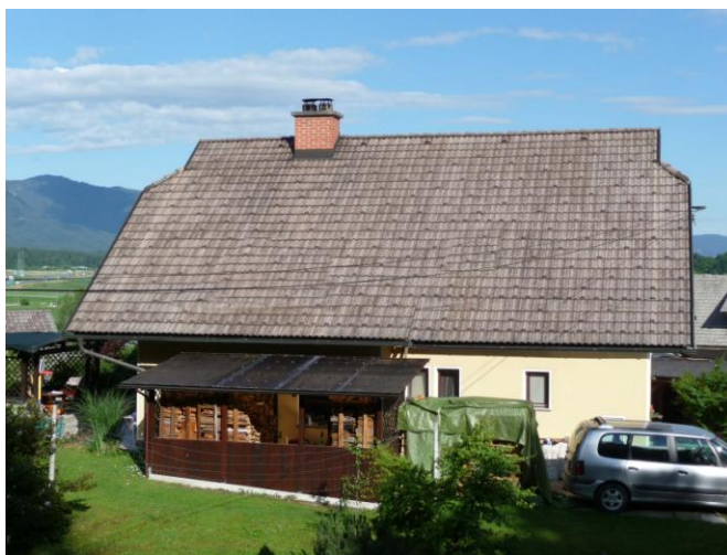
Slika 3: Streha pred postavitvijo SE (Vir: Lasten)
