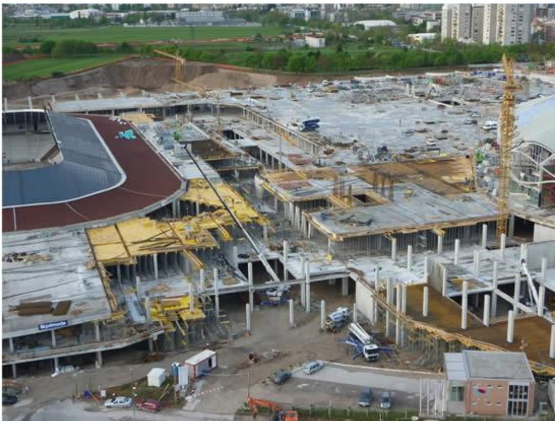
Slika 20: Večnivojske garaže in dovozne poti Športnega parka Stožice
