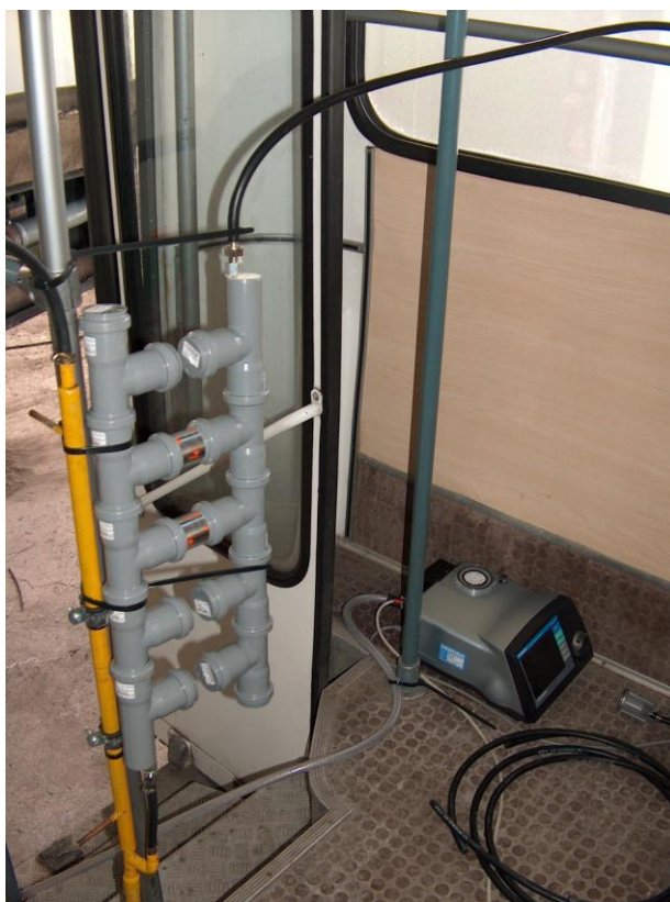
Slika 7: Filter izpušnih plinov (levo) in naprava za meritev sestave izpušnih plinov Horiba MEXA-548L, nameščena na avtobusu št. 329 (desno spodaj)
